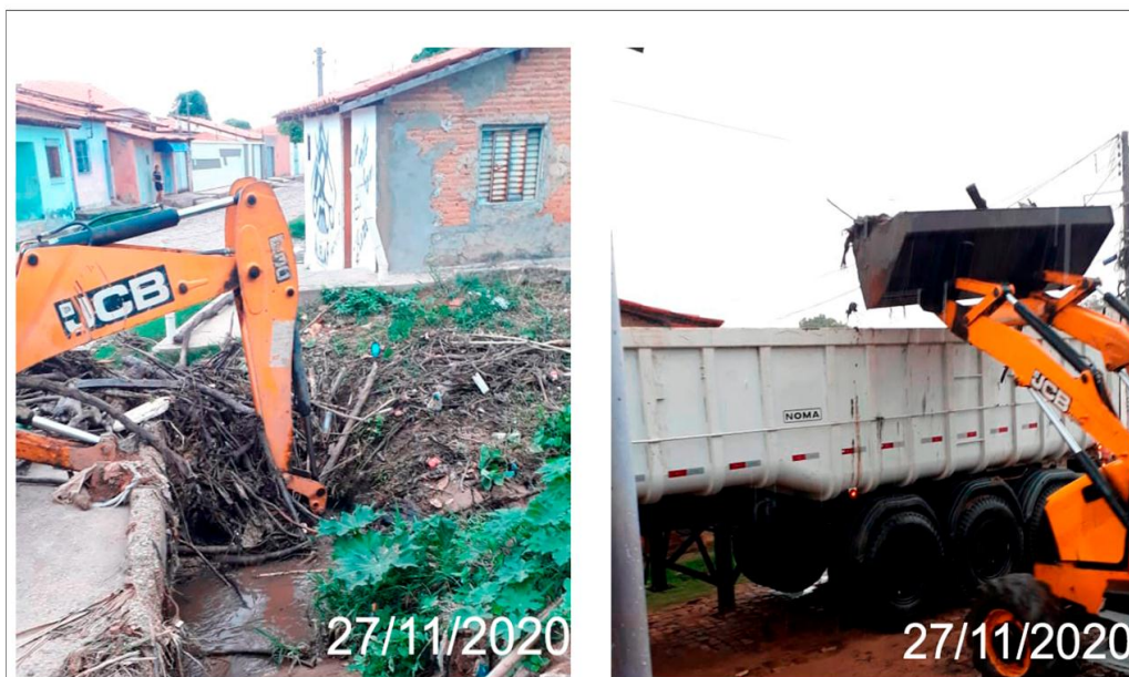
Figura 26: Ações de limpeza das valas e galerias da cidade de Florianópolis
