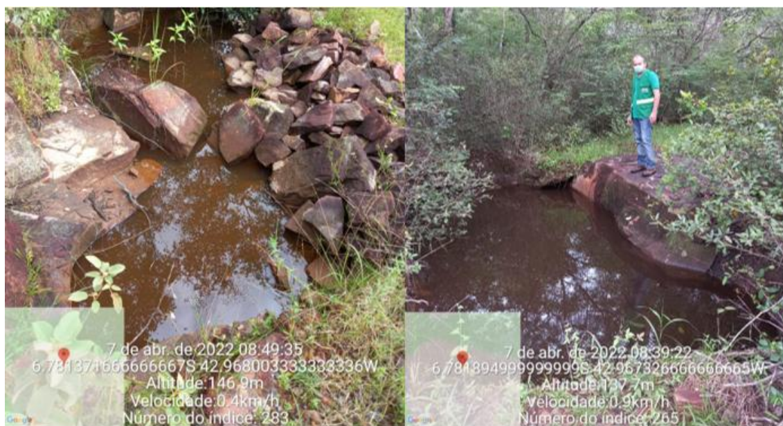
Figura 29: Identificação dos passivos ambientais entorno do aterro
